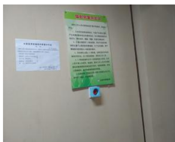
隧道内紧急停机按钮
