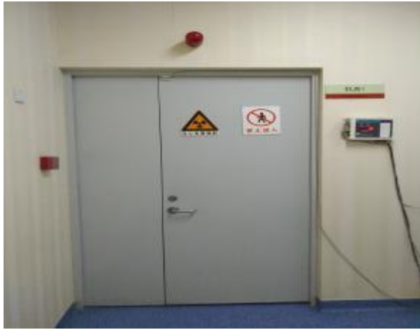
铅门辐射警示标志及工作状态显示灯
