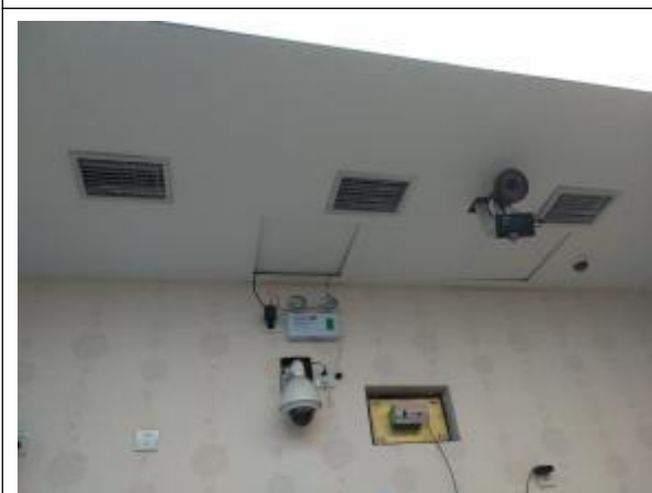
摄像头与紧急照明及通风口
