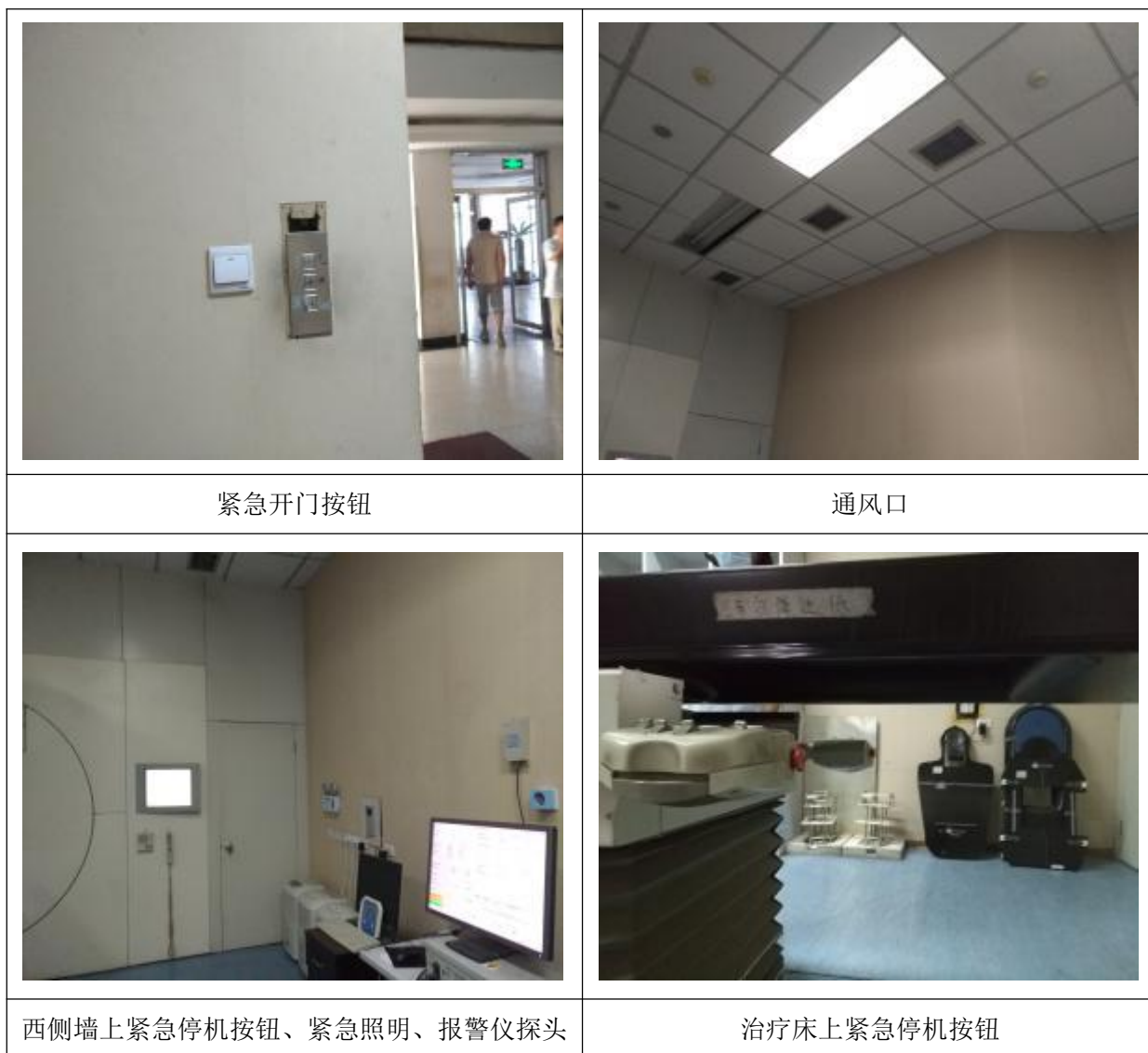
图 9-2 第二治疗室直线加速器现场检查照片
