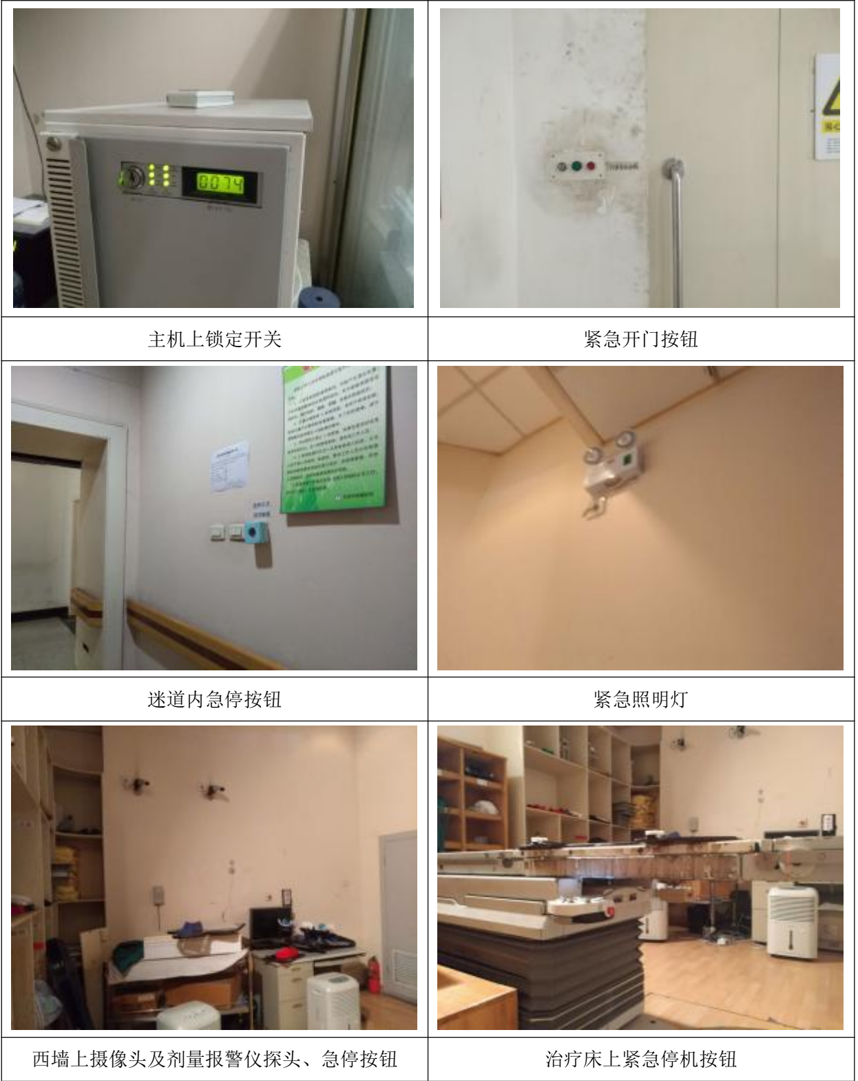
图 9-3 第四治疗室直线加速器现场检查照片
