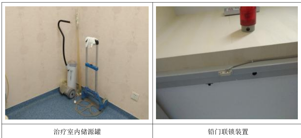
图 9-4 后装机房现场检查照片
