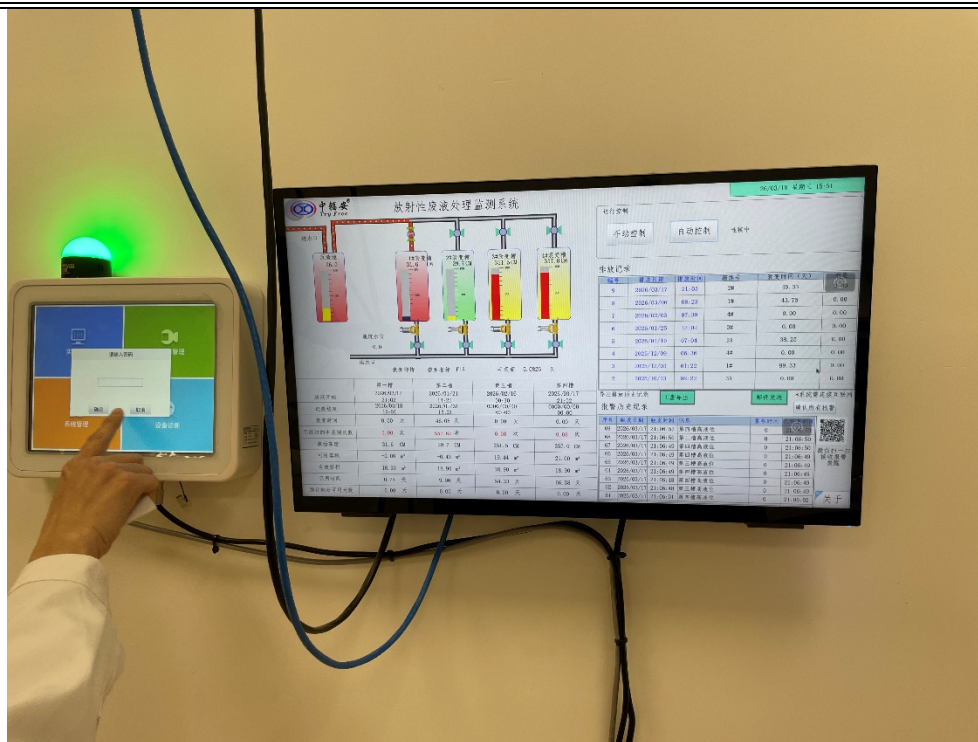
图 3-6 固定式 \gamma 辐射剂量率监测仪控制系统和衰变池监测系统(化学合成控制室内)
